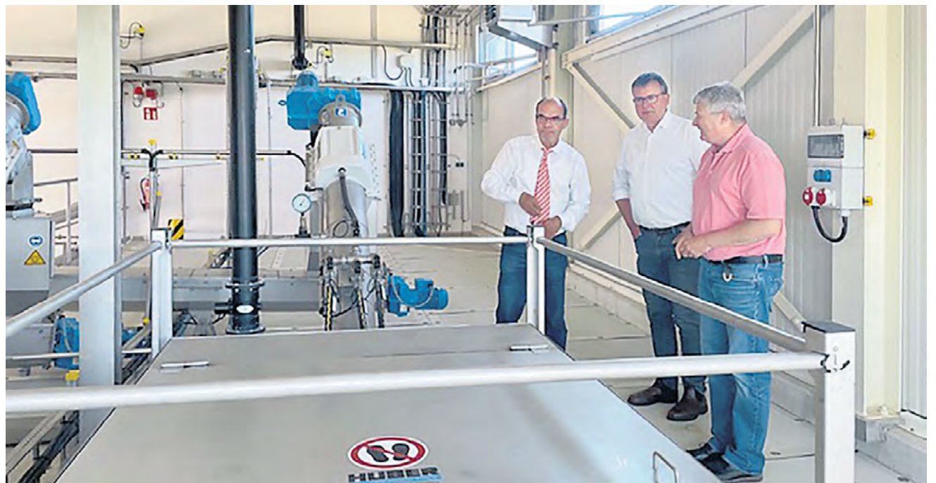
Verbandsvorsteher Thomas Seelbinder (links) und der Technische Leiter Thomas Hanke (rechts) präsentieren dem Landtagsabgeordneten Johannes Funke (SPD) stolz die Erneuerungen in der Kläranlage Roskow.
