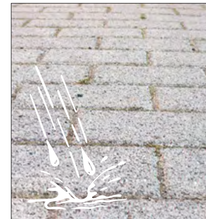
Ein simpler Schutz vor Überflutung des Grundstücks, von Gehwegen oder der Auffahrt – wasserdurchlässige Pflastersteine saugen den Niederschlag auf wie ein Schwamm und geben ihn nach unten weiter.
