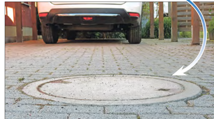
... zu einer unterirdischen Zisterne weiter, die etwa unter Ihrer Einfahrt dezent „versteckt“ werden kann. Ausgestattet mit einer elektrischen Pumpe kann das aufgefangene Wasser – so es nicht versickert – sogar in Trockenzeiten für die Bewässerung des Gartens wieder genutzt werden. Beachten Sie: Pumpen erfordern regelmäßige Wartung!
