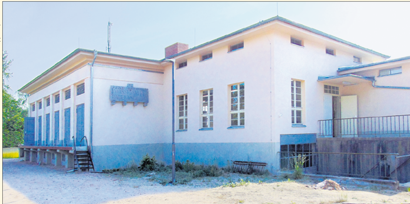
Schon heute erstrahlt die Fassade des Wasserwerks in neuem Glanz.
