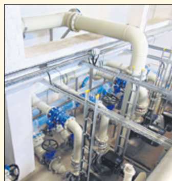
Auch im Innern des Wasserwerks wurden schon neue Anlagen installiert.
