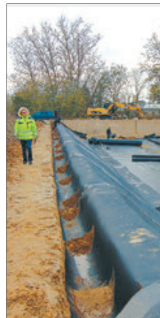
Die Bilder zeigen die Baustelle für ein Havariespeicherbecken bei Ketzin/Havel, wo derzeit fleißig verlegt und geschweißt wird.
