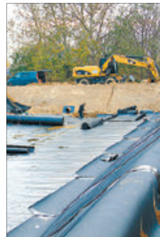
Die Bilder zeigen die Baustelle für ein Havariespeicherbecken bei Ketzin/Havel, wo derzeit fleißig verlegt und geschweißt wird.
