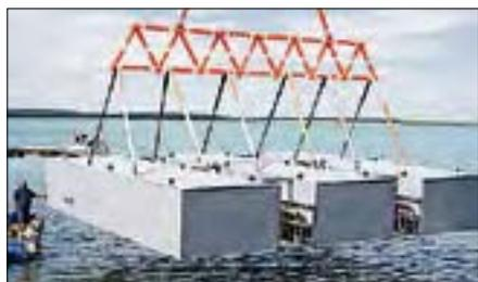
Ein Pontonsystem für ein schwimmendes Haus mit integrierten Spiralwärmetauschern.
