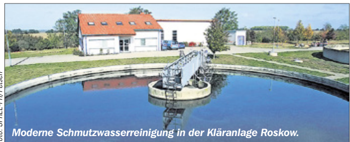
Moderne Schmutzwasserreinigung in der Kläranlage Roskow.
