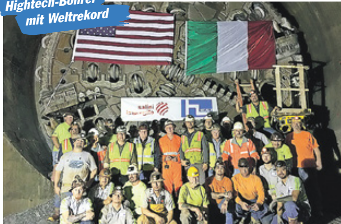
Eine Tunnelbohrmaschine (TBM) von Herrenknecht hat im US-amerikanischen Las Vegas gerade einen Weltrekord aufgestellt: Der Hightech-Bohrer musste 15 Bar Wasserdruck standhalten. Die Stadt bezieht ihr Wasser aus dem Stausee Lake Mead, doch dessen Wasserpegel sinkt. Um das Wasser zukünftig tief unten im See entnehmen zu können, bohrte sich die TBM drei Jahre lang durch widrigsten Untergrund.
