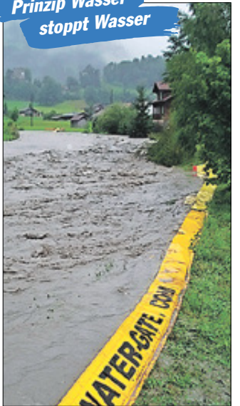
Water-Gate nutzt das Prinzip „Wasser stoppt Wasser“ und besteht aus geschickt angepassten PVC-Planen. Das Wasser fließt hinein und bewirkt, dass sich die Planen als Barriere selbständig entfalten und stabilisieren. Die Schutzhöhe beträgt bis zu 2m. Eine Rolle ist 15m lang und kann sofort tausende von Sandsäcken ersetzen. Die Barriere muss weder befestigt noch gefüllt, sondern einfach nur entrollt werden.
