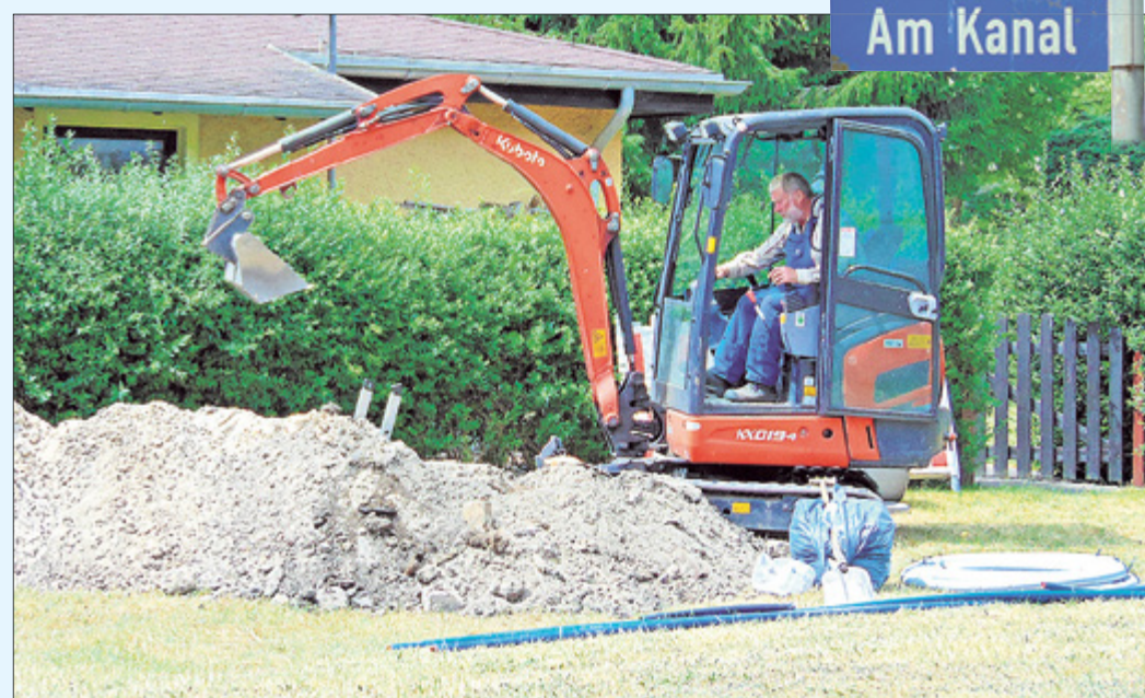
Beginn der Bauarbeiten für die Erschließung der Wochenendhaussiedlung in Deetz.
