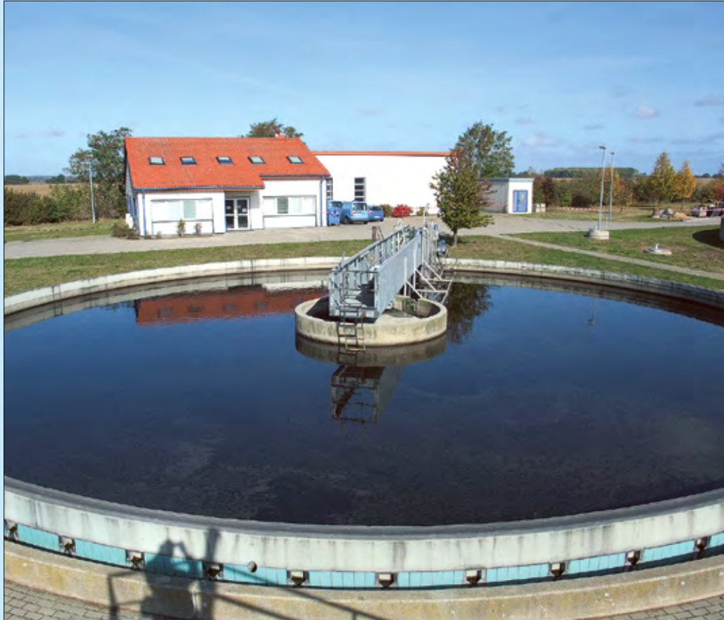
Der WAH hat in den vergangenen 20 Jahren viel Geld in seine Anlagen gesteckt – so wie in die Roskower Kläranlage (Foto). An diesen Investitionen müssen sich alle Kunden beteiligen.
